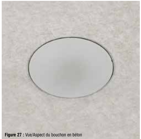
Figure 27 : Vue/Aspect du bouchon en béton
