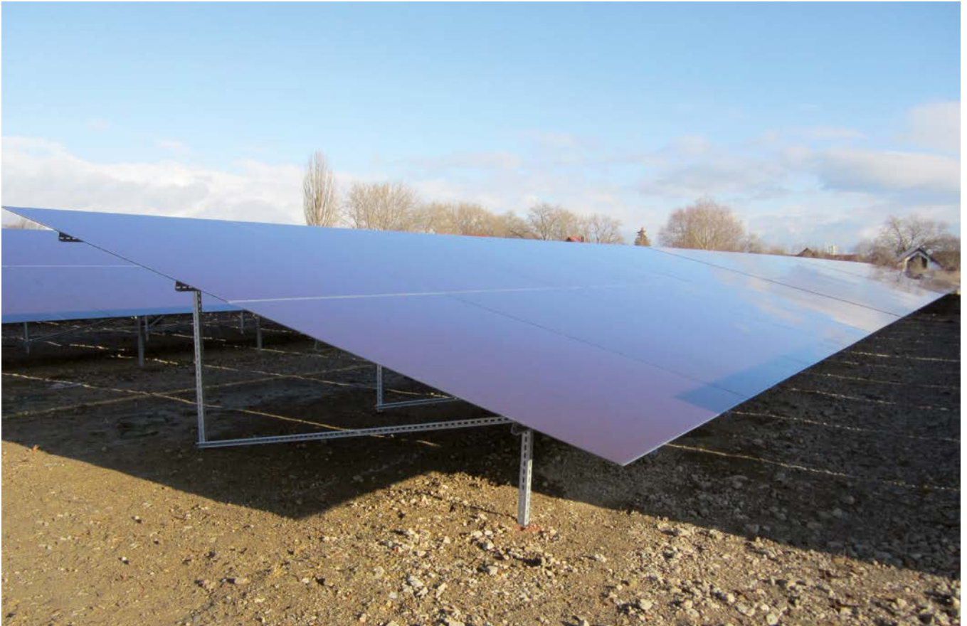
Module, Dünnschicht mit Back Rails, 2,6 x 2,2 m, 2-reihig, vertikal
