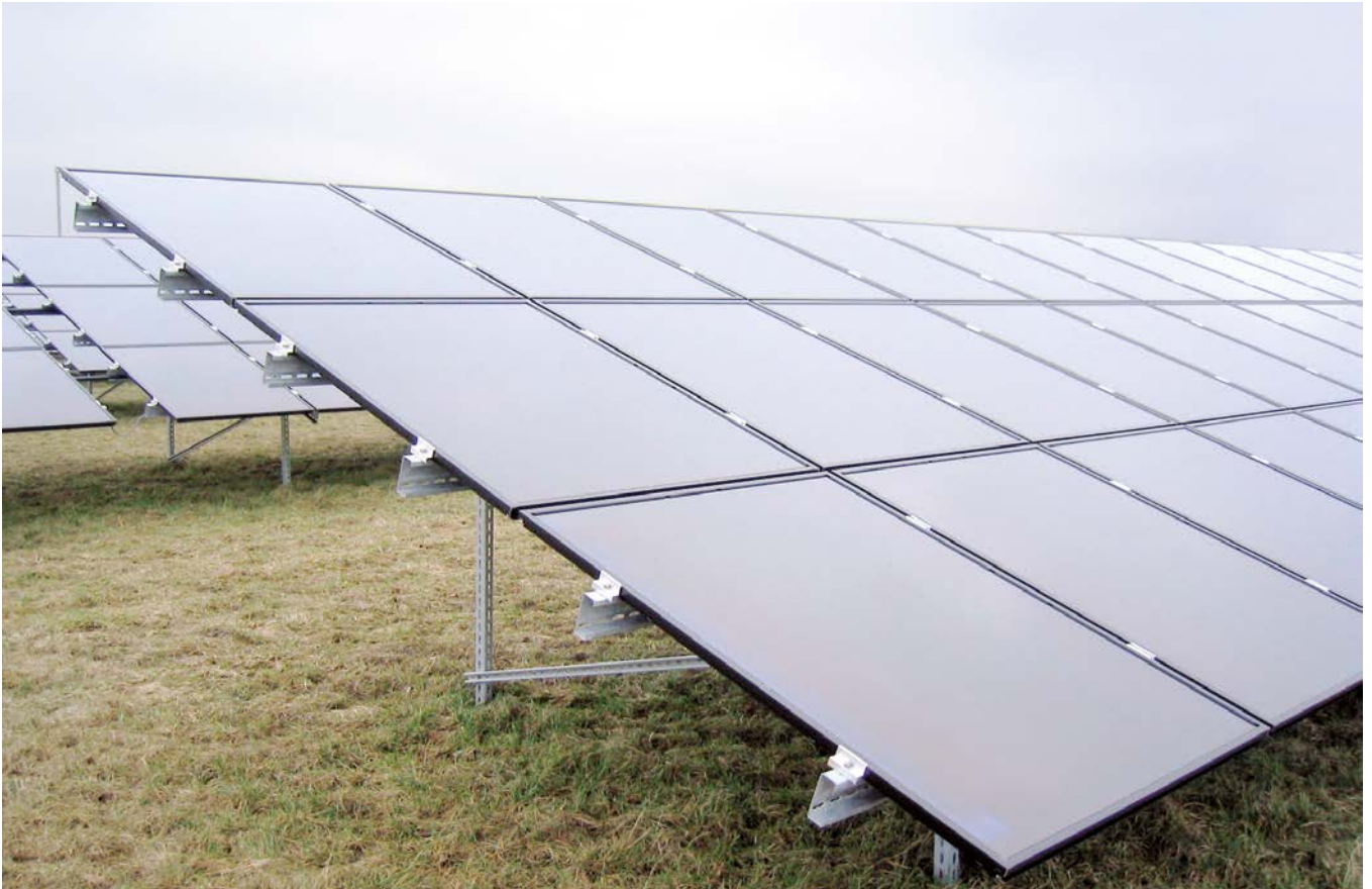
Module, Dünnschicht, gerahmt, 3-reihig, vertikal Modules, thin-film, framed, 3-rows, portrait
