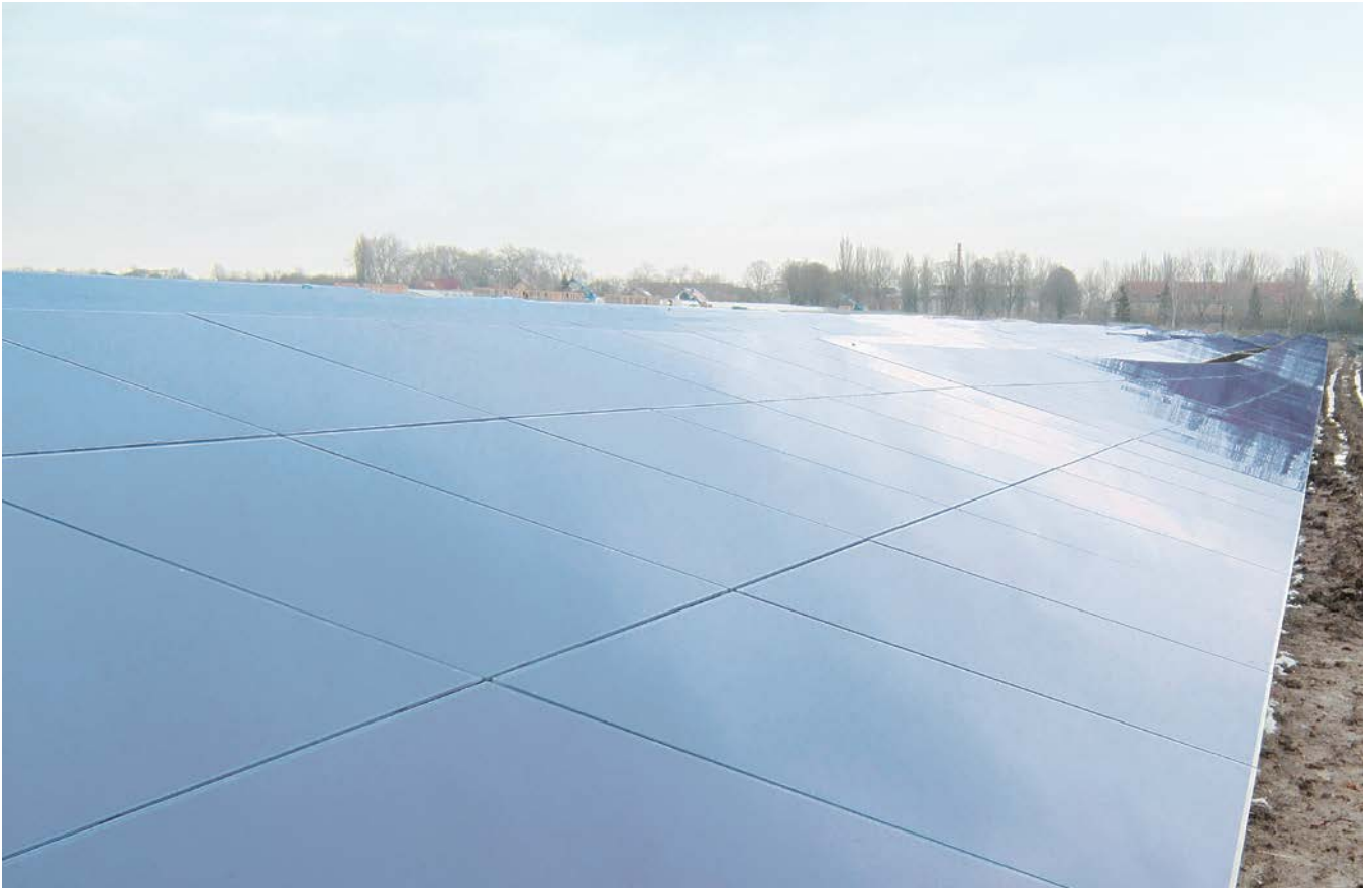
Module, Dünnschicht mit Back Rails, 1,3 x 1,1 m, 3-reihig, vertikal Modules, thin-film with back rails, 1.3 x 1.1 m, 3-rows, portrait
