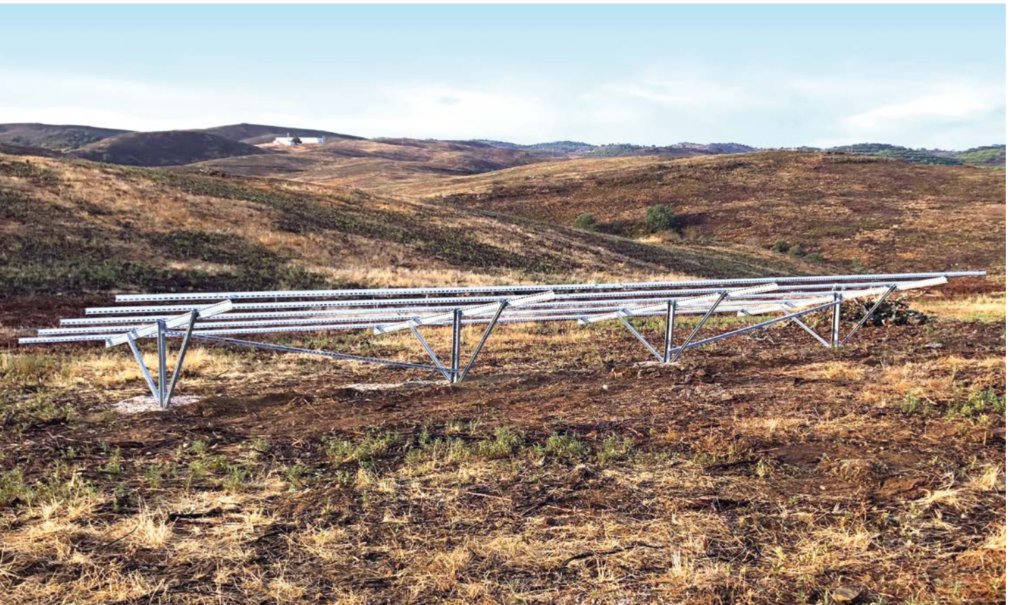
1-Stützensystem, Portugal 1-support system, Portugal
