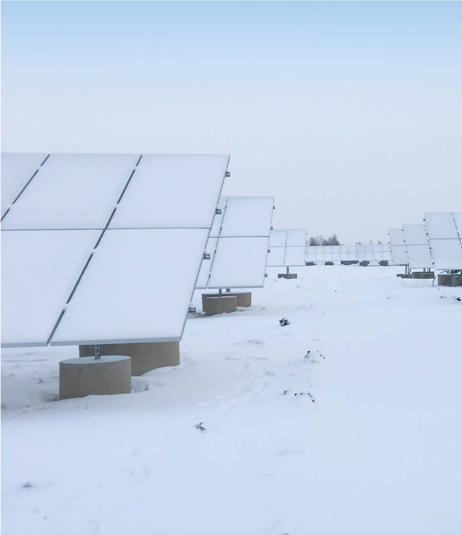
Solarpark Pärnu, Estland Solar plant in Pärnu, Estonia
