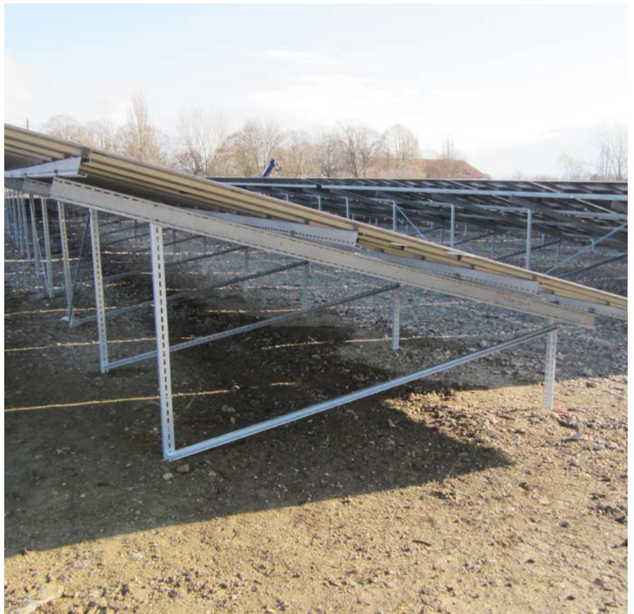
Module, Dünnschicht mit Back Rails, 2,6 x 2,2 m, 2-reihig, vertikal
