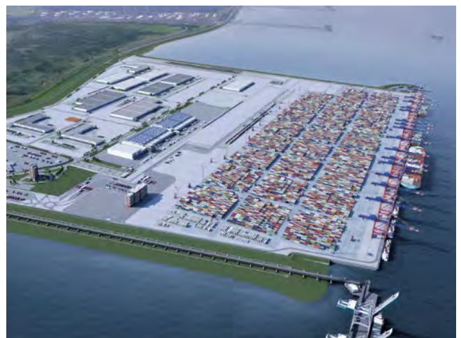
JadeWeserPort, Wilhelmshaven, Germany
